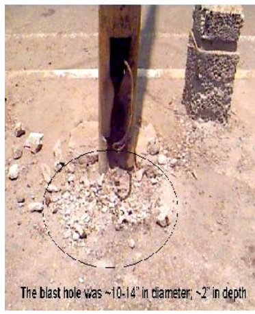
IED umieszczone w elementach infrastruktury drogowej.
