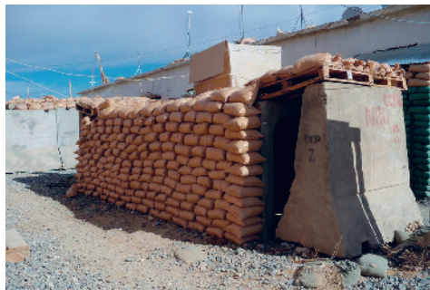
Fot. 79. Wykorzystanie worków do ochrony schronów żelbetowych.
