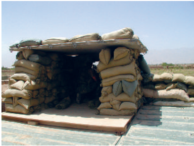
Fot. 76. Wykorzystanie worków do ochrony posterunku.
